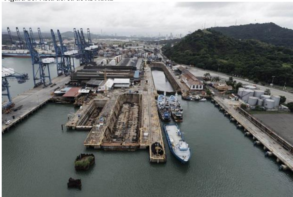
Figura 10. Vista aérea de ASTIBAL
